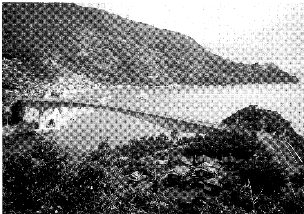
写真② 西側から見た上関大橋と上関海峡 (1997年9月写)
