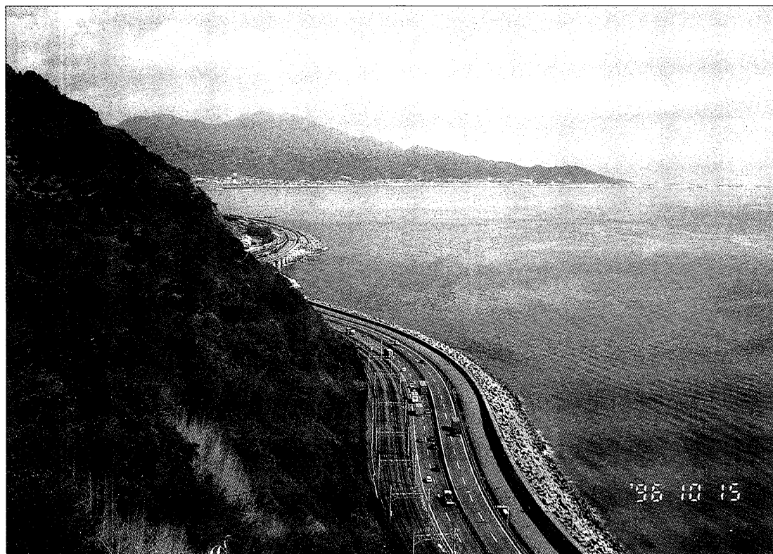
写真⑮ 江戸時代初期開削の薩埵峠から北東方をみる、鉄道は東海道本線、道路は国道1号線（1996年10月写）
