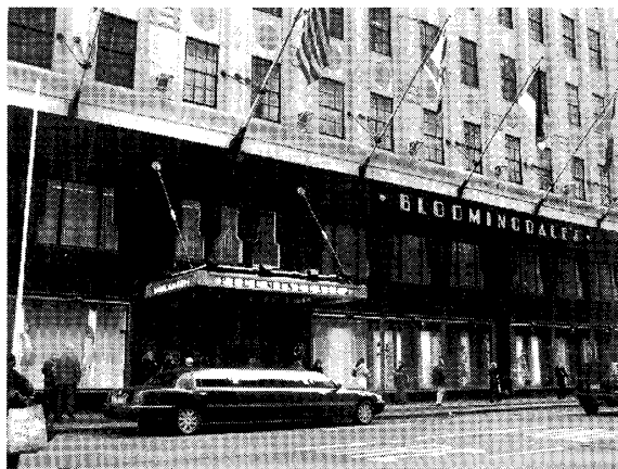
写真1 ニューヨーク ブルーミングデールズ 伝統的な百貨店建築で、外見からは拡張の様子ははっきりしない。(2004年3月撮影)
