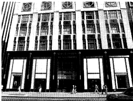
写真4 ニューヨーク バーグドルフ・グッドマン (男店) 別の建物から用途を転用しているようで内部は複雑で使い勝手は良く無いが、外観は高級感を打ち出している。
