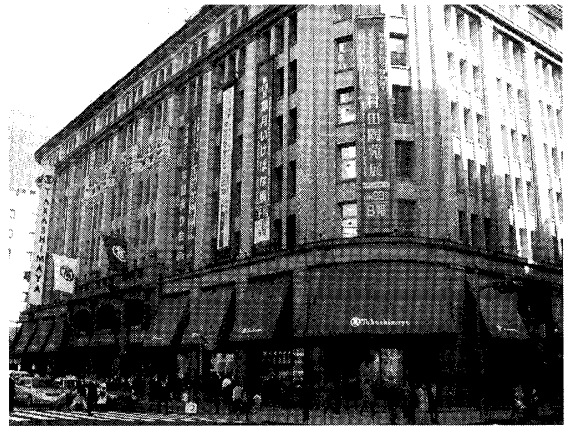
写真22 東京日本橋高島屋東京店
