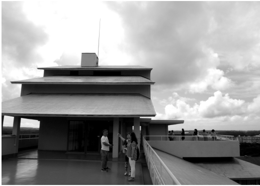
写真9 ザクラシック屋上の塔屋
