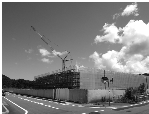
写真10 解体中の国際メディアセンター アネックス (2016年8月25日筆者撮影)
