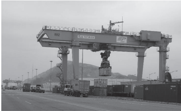
図表16 釜山新港の鉄道貨物施設のヤード積載施設
