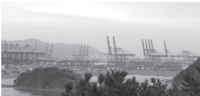
図表9 釜山新港の整備状況
